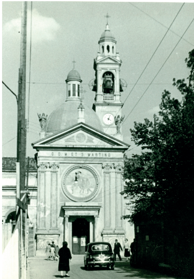
Fondo Alberto Rigotti. Data: anni '50 del XX secolo. Facciata della chiesa di San Martino, Foto scattata dal padre di Alberto Rigotti
